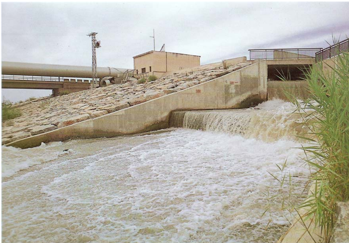
Post-Trasvase: Los regadíos de la Vega Baja se pueden abastecer desde hace poco directamente desde el Post-Trasvase mediante este vertido desde el sifón de Orihuela al Río Segura (Septiembre de 1995).
